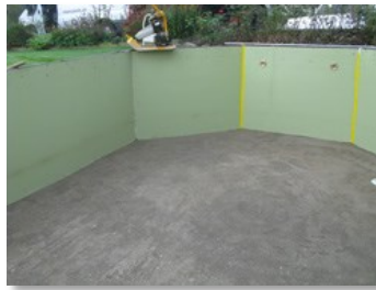
Stabile und beständige Kunststoffplatten werden als zweiter Beckenkörper verlegt
