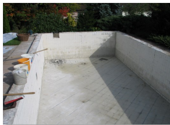
Nach dem Entfernen der Fliesen wird ein Vlies und eine
