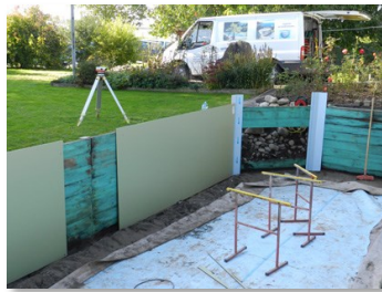
Stabile und beständige Kunststoffplatten werden als zweiter Beckenkörper verlegt
